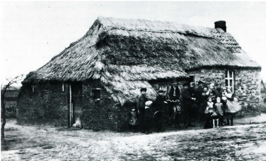
„Zwei Butzen (Schlafstellen), 9 Personen: je 3 u. 6 in einem Bett, für Wohnraum: 15,21 qm“ lautet der Text zu diesem Foto, das einer 1927 erstellten Dokumentation über die katastrophalen Wohnverhältnisse Moordorfs entstammt
